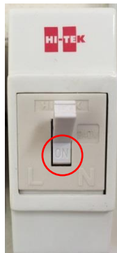
รูปภาพที่ 4- 2 สะพานไฟที่ใช้ในการส่งผ่านกระแสไฟฟ้าไปยังเครื่องขยายเสียงประจำห้องเรียน
